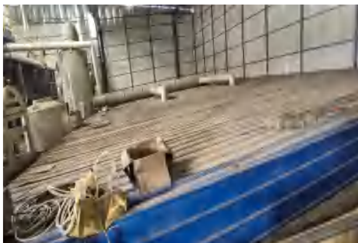
污水处理系统废气收集设施
