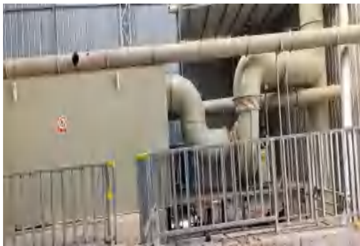
DA006 废气处理系统（生物滤池除臭设备）
