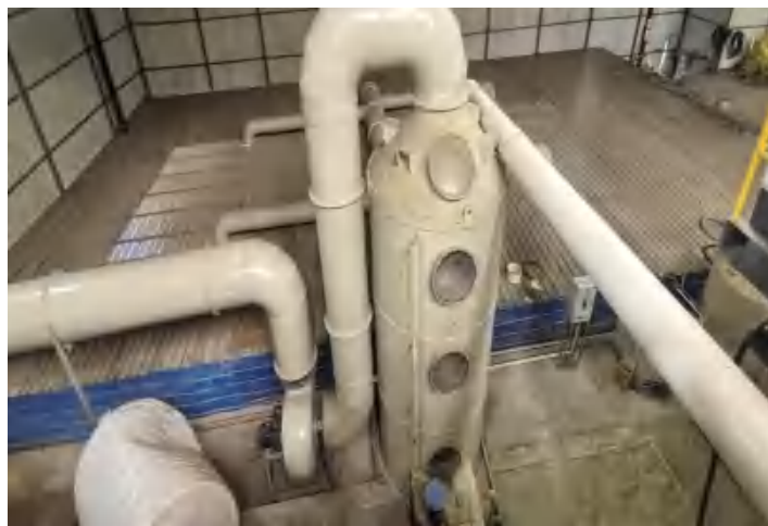
DA005 废气处理系统（化学吸收除臭设备）
