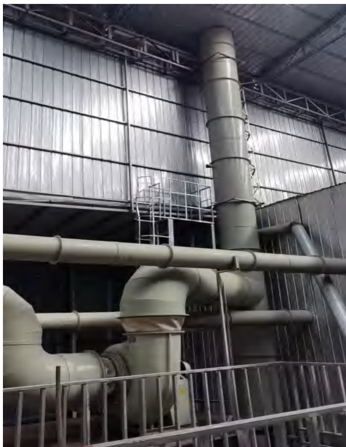
DA006 废气处理系统排气筒及平台
