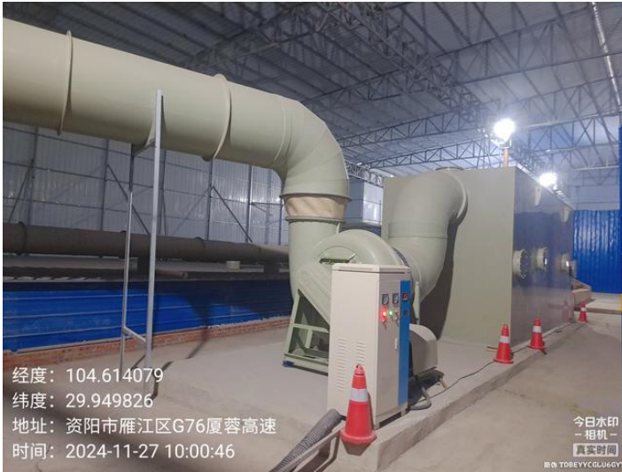
废气处理系统（生物除臭设施）
