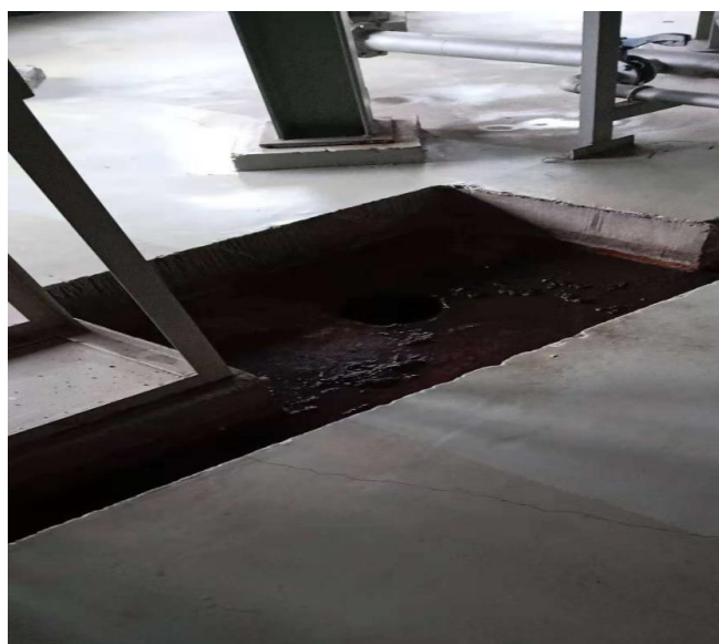
泵房废水收集坑
