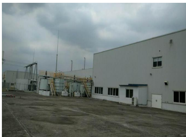
污水处理站地下贮存池
