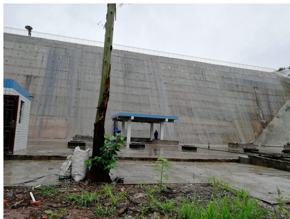
垃圾坝（水泥硬化）
