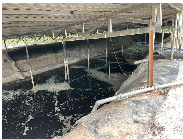
2#调节池和3#调节池内部情况（采用水泥硬化+土工布+土工膜+土工布防渗）
