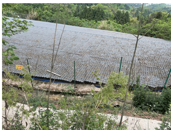
2#调节池（暂存池）
