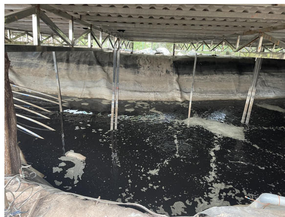
2#调节池和3#调节池内部情况（采用水泥硬化+土工布+土工膜+土工布防渗）
