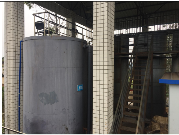
渗滤液处理站接地储罐（二级絮凝）
